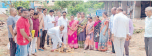
ప్రహరీ నిర్మాణానికి శంకుస్థాపన చేస్తున్న చైర్మన్ చంద్రారెడ్డి
